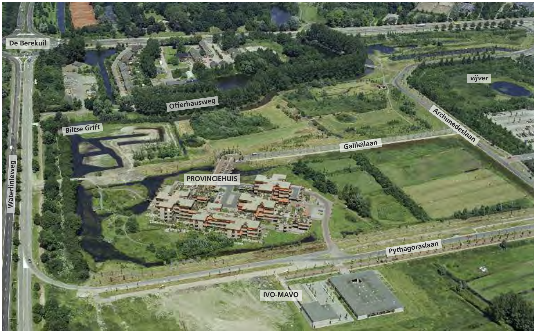
Deze foto van Park Bloeyendael is in 1979 gemaakt vanaf het zuiden. Het provinciehuis (nog zonder hoogbouw) stond destijds aan de Galileïlaan. Rechtsboven (vijver) staat nu het provin-
